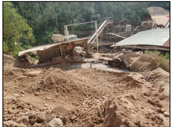
冲洗投料位置
