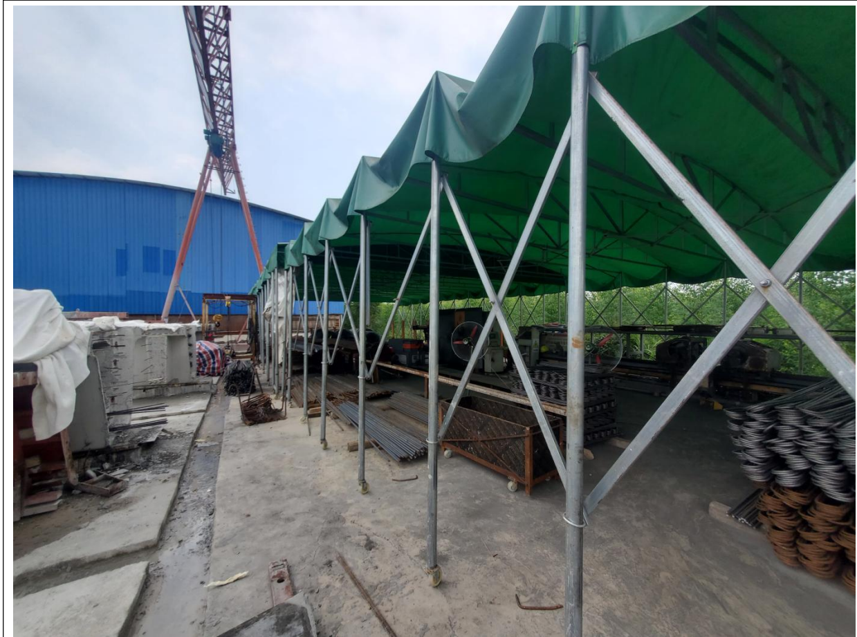
复垦前现场情况
