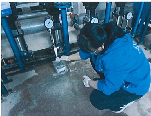
南景湾山水城采样口
