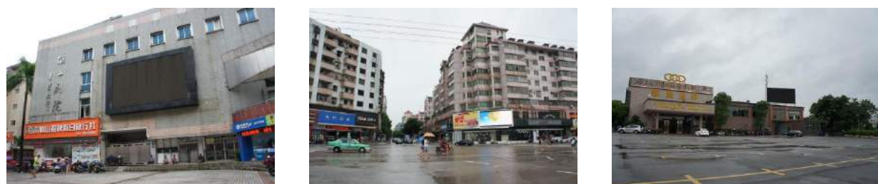
图 2-5 电子屏广告牌实拍照片
