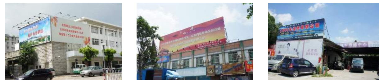
图 2-3 依附楼顶户外广告牌实拍照片
