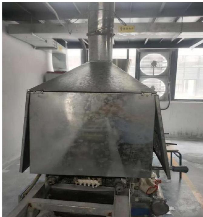
图 4-2 (2) 色母粒和改性塑料工序的净化排风口
